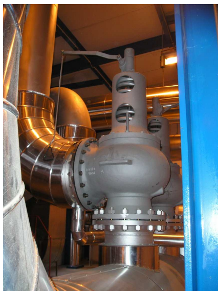
Obr. 01- Přímočinný pojistný ventil
