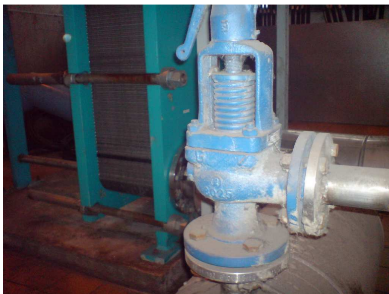
Obr. 19-Pojistný ventil s přetaženou pružinou
